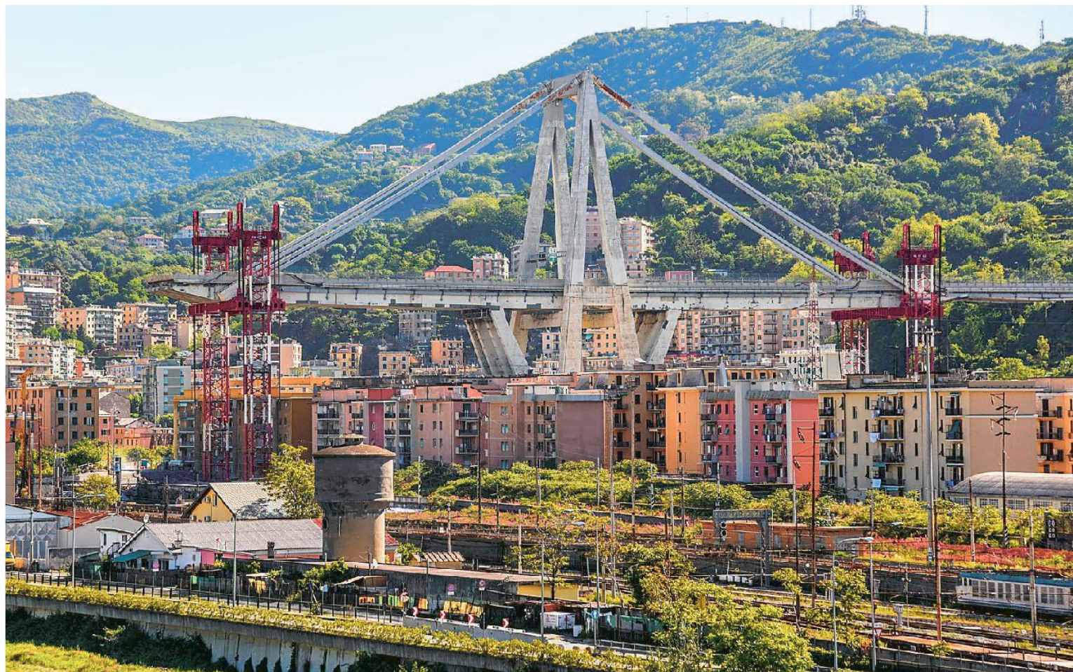
La pila 10 del Morandi sostenuta dalle due mega torri
